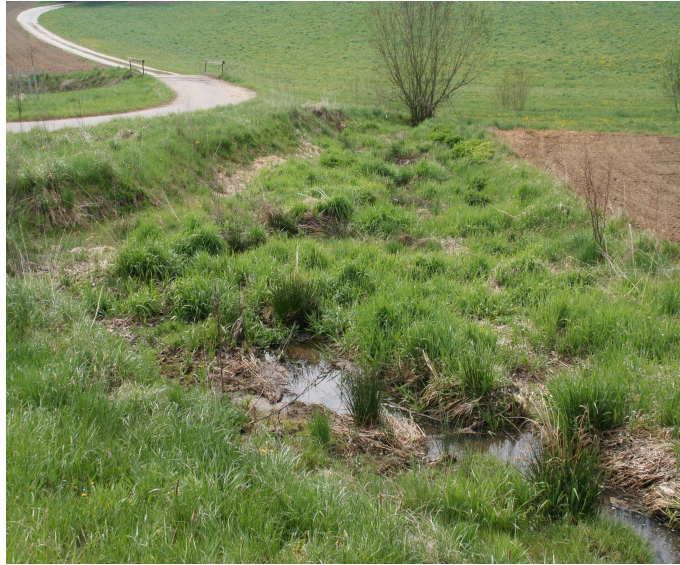
Abb. 8: Aufweitung und Verkrautung eines Grabens zum Stoffrückhalt bei Altenkirchen. Umsetz.modell: Landwirt + Kommune (eigene Aufnahme)
